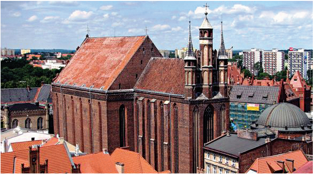
6 Kościół Wniebowzięcia Najświętszej Marii Panny w Toruniu budowany był etapami od 1343 roku aż do końca XIV w.
