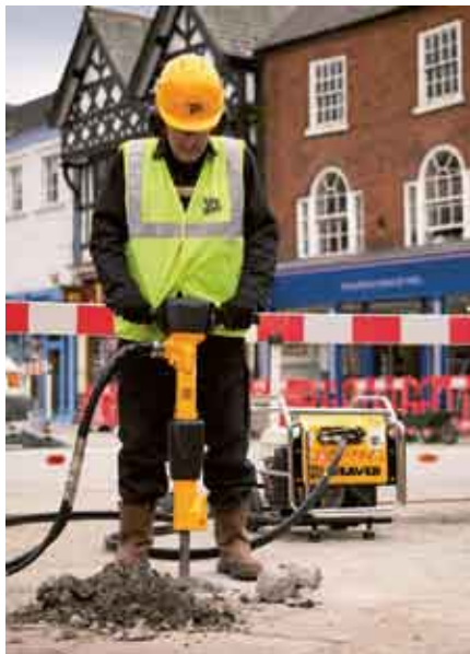
Ryc. 19.3 Długotrwała praca z użyciem młota pneumatycznego może spowodować uszkodzenie słuchu i chorobę wibracyjną, dlatego wykorzystanie tego narzędzia wymaga szczególnej ostrożności i stosowania zasad BHP
