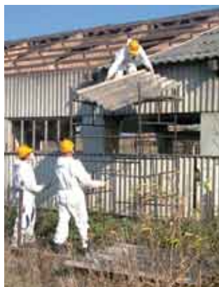
Ryc. 6.15 Eternit to mieszanina cementu i azbestu. Obecnie już się go nie stosuje w budownictwie
