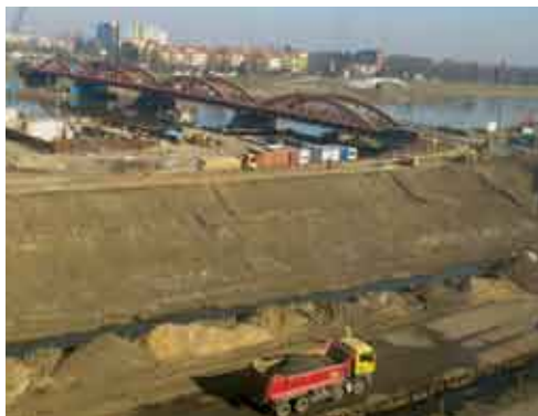
Ryc. 34.4 Przebudowa jazu na Odrze i umacnianie wałów po „powodzi tysiąclecia” we Wrocławiu
