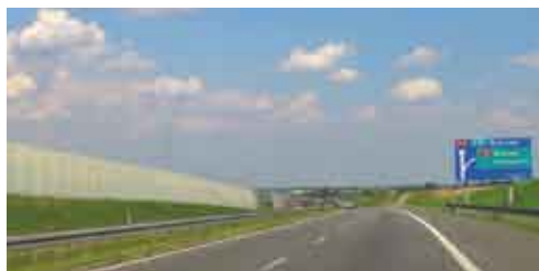
Ryc. 39.5 Autostrada A4 koło Krakowa. Ekrany akustyczne (po lewej), chroniące osiedla przed hałasem, są częstym elementem podmiejskiego krajobrazu
