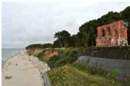
Ryc. 10.3 Ruiny kościoła na klifie w Trzemesznie. Zwróć uwagę na wąską plażę i zabezpieczenie ściany klifu przed dalszym osuwaniem się.
