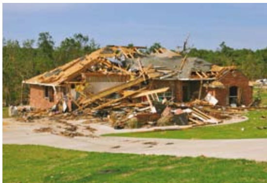
Ryc. 5 Dom zniszczony przez trąbę powietrzną
